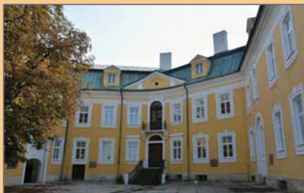
Oprava zámku pokračuje – v září byla dokončena nová fasáda
