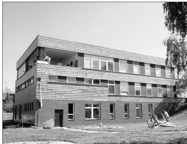
Byly zatepleny budovy Základní školy Komenského a Mateřská škola na Wolkerově ulici.
