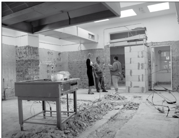
Rekonstrukce kuchyně ZŠ Komenského, vzduchotechnika. Provedeno se státní podporou v přibližné výši 94% z celkových finančních nákladů.
