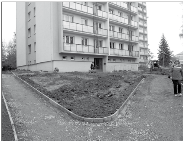
Regenerace panelových sídlišť - byly realizovány dvě etapy, třetí je připravena pro podání žádosti o dotaci.
