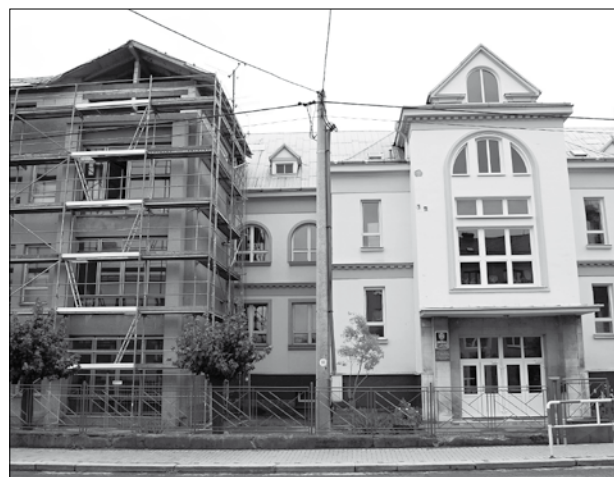
Nadstavba ZŠ TGM, panelového objektu na Ostravské ul.
