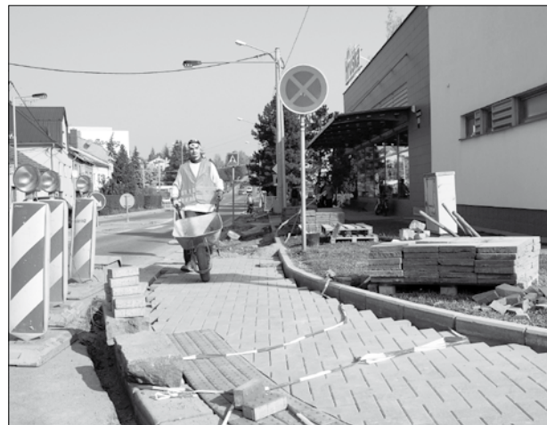
Rekonstrukce chodníků podél silnic 1. třídy - Labuť, Nová cesta, 17. listopadu, Ostravská ulice a na Opavské ulici. Byly vybudovány přechody pro chodce.
