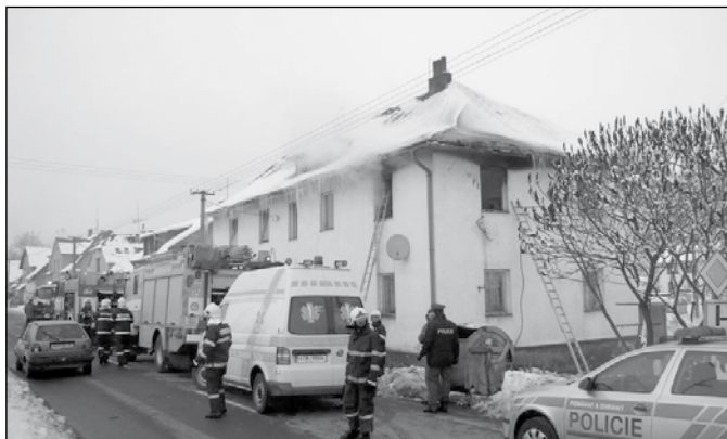
Požár ubytovny v Bílovci, ulice Opavská, na místě HZS Bílovec a Nový Jičín, JSDH Bílovec, Slatina, Tisek, ZZS, PCR, MP.
