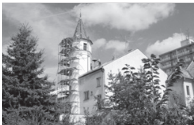
Srpen 2008, oprava hasičské zbrojnice v Bílovci
