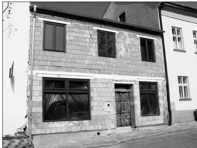
Objekt v době rekonstrukce
