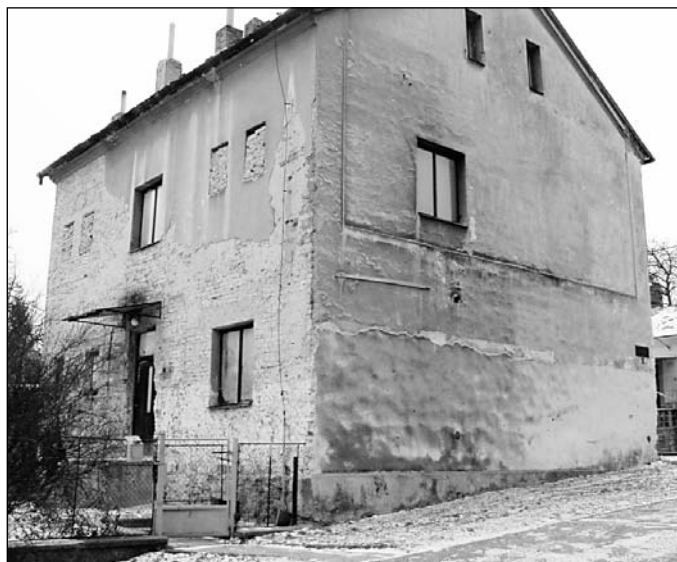
Dům před rekonstrukcí
