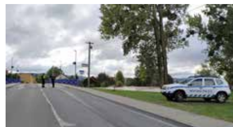
V sobotu došlo k uzavření mostu na Dvůrisko.
