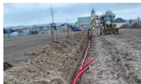
Stavba dešťové kanalizace.
