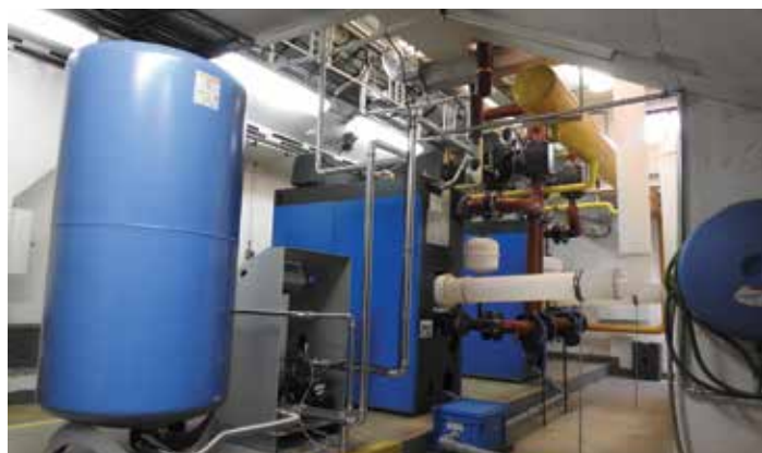
V říjnu byla ukončena rekonstrukce plynové kotelny v ZŠ Kravaře panem Romanem Šugarem včetně elektroinstalace, prováděné p. Leošem Peterkem v celkových nákladech cca 2.000.000 Kč. Rekonstrukce je plně hrazena dotačními tituly.
