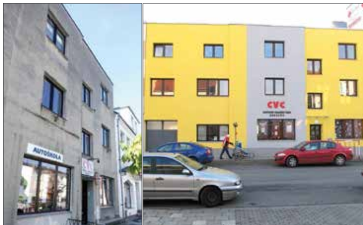
CVČ Kravaře stav před a po zateplení průčelí.
