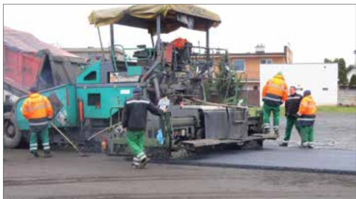
Stavební práce na pokládce obrusné vrstvy pro odstavnou a manipulační plochu.
