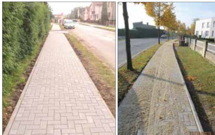
Vlevo nový chodník na ul. Bolatická, vpravo nový chodník na ul. Štěpánkovická.
