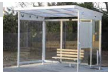
Nová autobusová zastávka na ulici Štěpánkovická.
