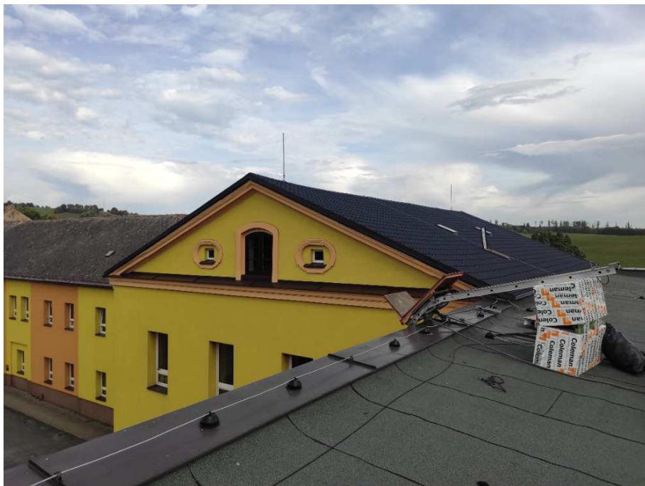
Foto opravené střechy na budově ZŠ Andělská Hora
