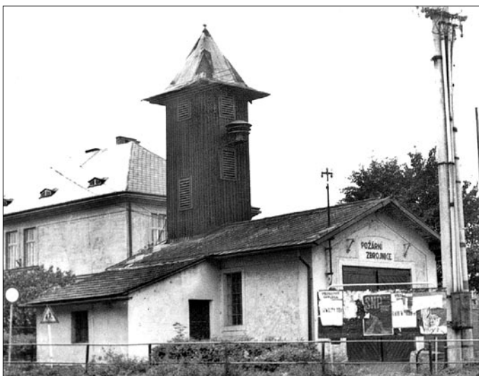
První požární zbrojnice v Albrechticích byla postavena v roce 1910.
