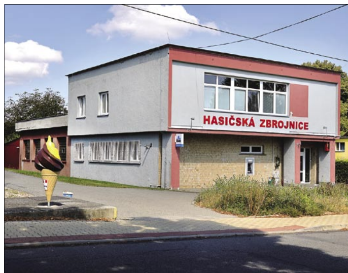
Nová požární zbrojnice byla v naší obci slavnostně uvedena do provozu 30. srpna 1975.
