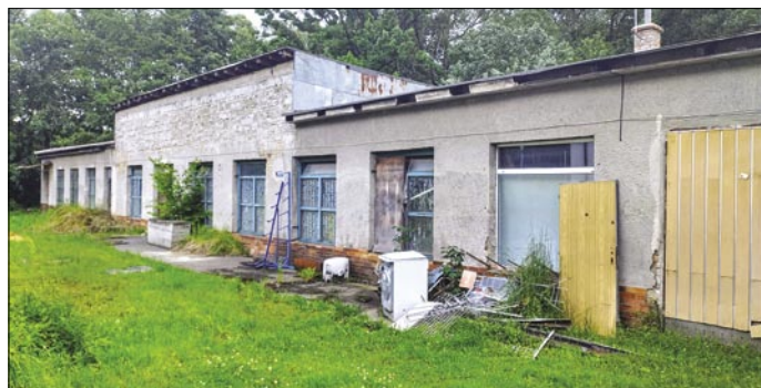
Smutný pohled na bývalý obchod, kde bývalo k sehnání vše. Tato budova již několik let bez využití chátrá.
