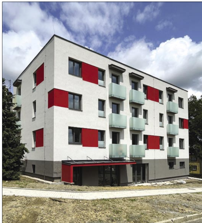
Výstavba komunitního domu je před dokončením.
